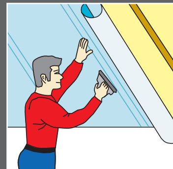
Verlegung und antackern der Dampfsperrbahn
